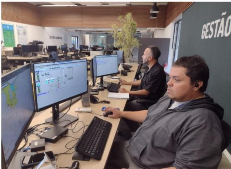
Figura 3 – Foto dos Operadores utilizando o Sistema Supervisório (SCOA)
