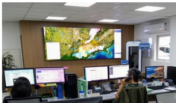
Figura 2 – Instalações do CCM Sede
