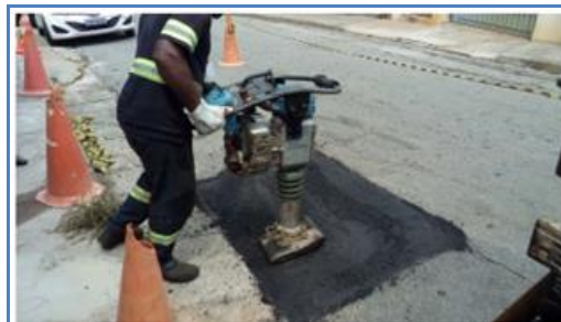
Figura 7. Aplicação do asfalto prático em serviço de manutenção
