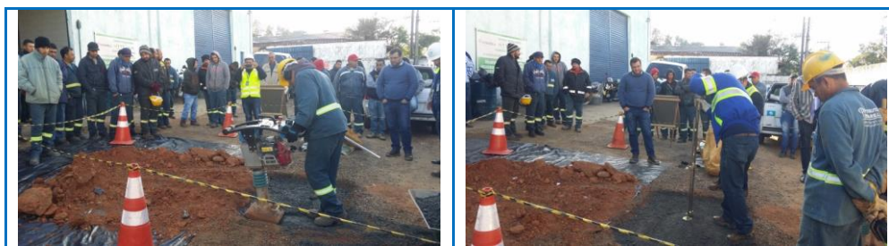
Figura 4. Treinamentos Asfalto Prático e DCP em canteiro de serviços da contratada
